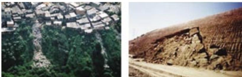
FIGURA 4. A) ILUSTRAÇÃO DE ÁREAS DE ALTA DECLIVIDADE NAS QUAIS SÃO LANÇADOS LIXO E ENTULHO. QUANDO DO REGISTRO DE CHUVAS PROLONGADAS, ESSES LOCAIS SÃO DOS PRIMEIROS A REGISTRAR A OCORRÊNCIA DE ESCORREGAMENTOS. B) ESCORREGAMENTO EM CUNHA, REGISTRADO EM MACIÇO DE ROCHA ALTERADA. NOTAR QUE A MASSA MOBILIZADA FOI DELIMITADA PELA INTERSECÇÃO DE DOIS PLANOS DE ESTRUTURAS.
