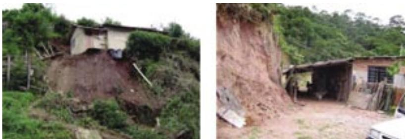
FIGURA 3. A) ESCORREGAMENTO PLANAR DE SOLO EM “ATERRO LANÇADO”. B) CICATRIZ DE ESCORREGAMENTO PLANAR DE SOLO EM TALUDE DE CORTE INCLINADO, DE PEQUENA ALTURA.
