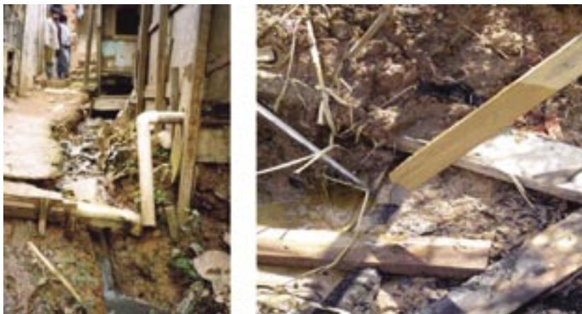
FIGURA 12. A) LANÇAMENTO DE ÁGUA E DE ESGOTO NA SUPERFÍCIE DO TERRENO. B) SURGÊNCIA DE ÁGUA NO TALUDE.
