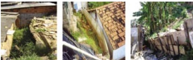
FIGURA 11. MUROS ENCURVADOS, INDICATIVO DA IMINÊNCIA DE RUPTURA.
