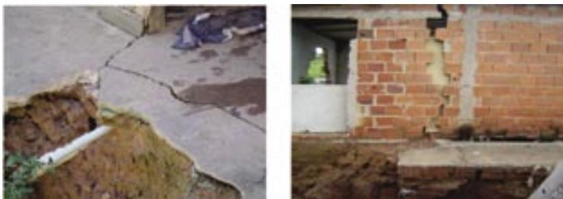
FIGURA 10. A) PRESENÇA DE TRINCAS NO PISO DE MORADIA. B) MORADIA COM PAREDES TRINCADAS EM RAZÃO DE INSTABILIDADE DO TERRENO.
