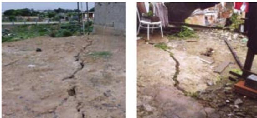
FIGURA 8. FEIÇÃO DE INSTABILIDADE DO TIPO TRINCAS NO SOLO E EM ATERRO.
