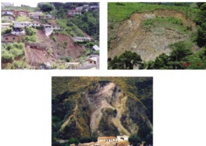
FIGURA 2 – ESCORREGAMENTOS PLANARES, CIRCULAR E EM CUNHA.
