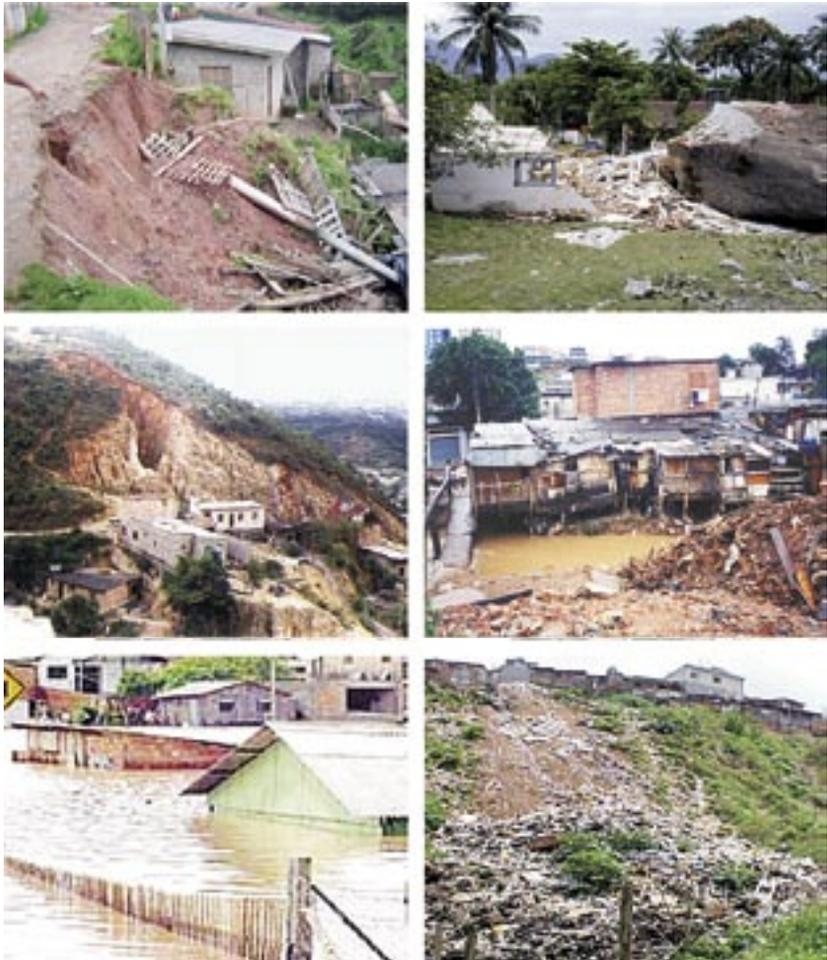
FIGURA 2. A) ESCORREGAMENTOS; B) QUEDAS DE BLOCOS ROCHOSOS; C) DESABAMENTOS DE MORADIAS PROVOCADAS POR EROSIÃO; D) DESABAMENTOS DE MORADIAS POR SOLAPAMENTO DE MARGENS DE CÓRREGOS; E) INUNDAÇÕES; F) DESLIZAMENTOS DE ATERROS, LIXO E DE ENTULHOS LANÇADOS NAS ENCOSTAS.
