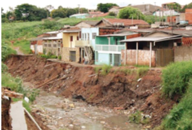
*Figura 5.8 – Situação de risco associada a erosão e solapamento dos taludes marginais, com ocupação ribeirinha.*
