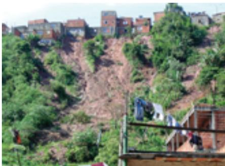
*Figura 3.7 – Deslizamentos planares induzidos pela ocupação.*
