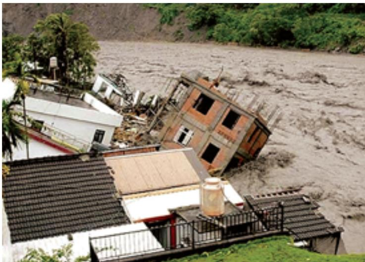
*Figura 5.13 – Situação de risco associado a enchentes e inundações com alta energia cinética e alta capacidade de erosão e arraste.*
