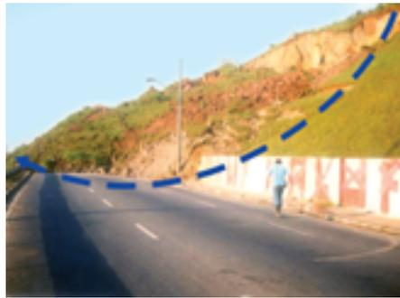
Figura 3.9 – Deslizamento circular ou rotacional.
