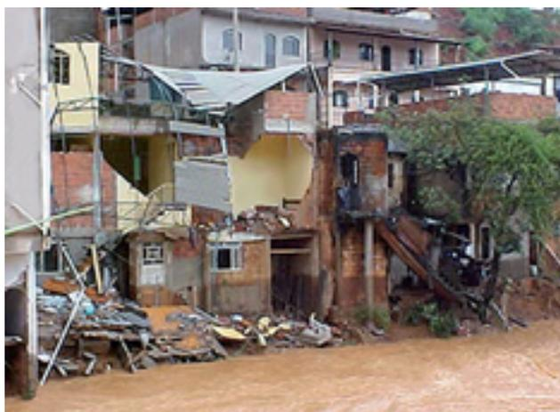
*Figura 5.12 – Situações de risco associado a enchentes com alta energia de escoamento.*
